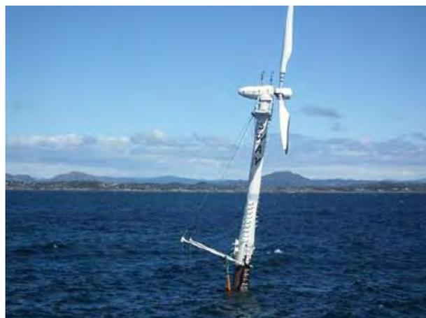
图 1-9 Sway 公司 Spar/TLP 混合结构式风机基础<sup>[25]</sup>
