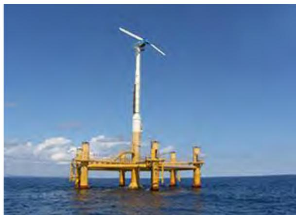
图 1-8 海上风机半潜式基础示意图
